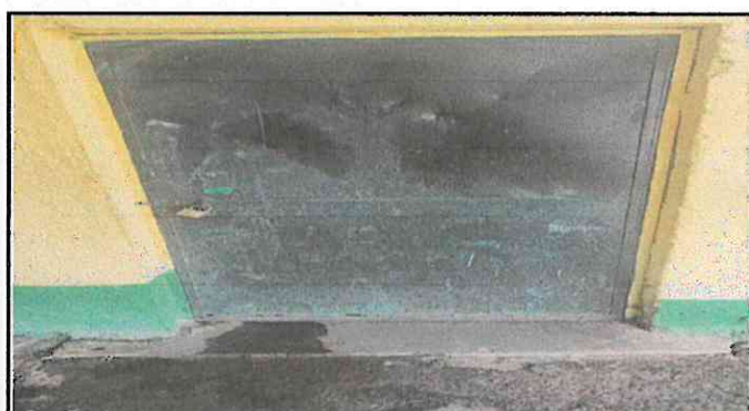
Foto 4: Sustitucion de puerta metalica.
