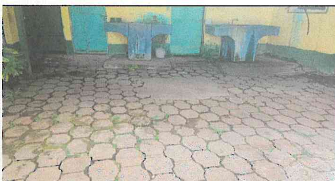
Foto 6: Sustitución de pilas y piso por torta de concreto.
