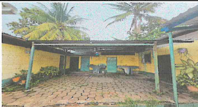
Foto 2: Mantenimiento a estructura metalica y sustitución de lamina por lamina troquelada y reparación de baños.
